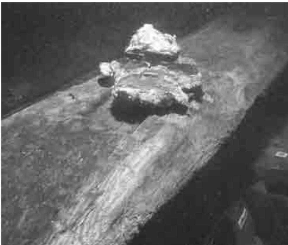
**Fig. 140.** Les vestiges d'une broche métallique, au centre d'une mortaise rectangulaire en face supérieure de la carlingue St 82, révèlent la présence d'un élément architectural disparu. (photo T. Seguin)
