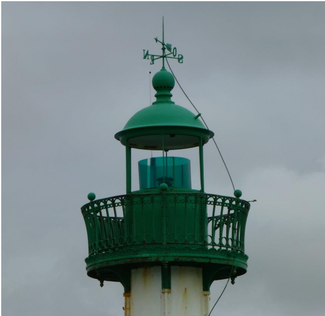
Détail de la lanterne avec sa balustrade circulaire en fonte, sa coupole en cuivre, sa girouette et son paratonnerre
